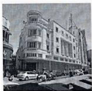
ساختمان موسوم به «جیب» در منطقه 12 تهران
