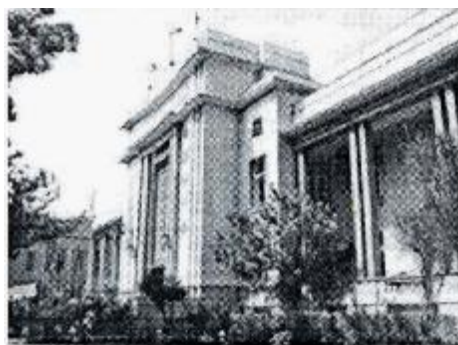
ساختمان مرکزی بانک سپه
