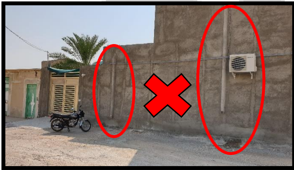
اجرای تاسیسات در نما
