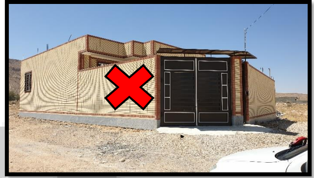
احداث درب ماشین رو در قسمت پخ
